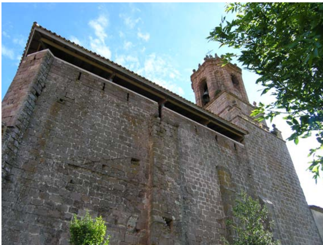
Iglesia fortaleza de Mirafuentes. Se aprecian las saeteras y los matacanes sobre los contrafuertes, que eran aprovechados como torrecillas atalayas. Contaba con alcaide y ballesteros para protegerla.
